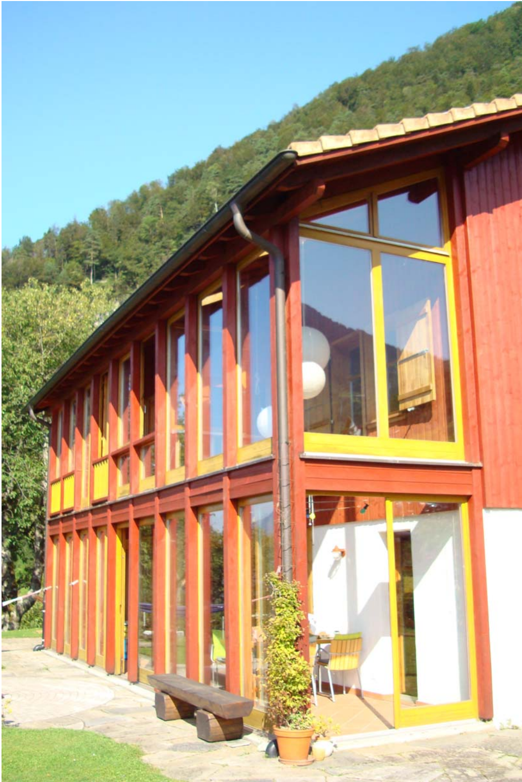
Der zweigeschossige Wintergarten auf der Südseite dient als zusätzlicher, attraktiver Wohnraum und beeinflusst den Energiehaushalt des Gebäudes positiv. (Bild 5)
