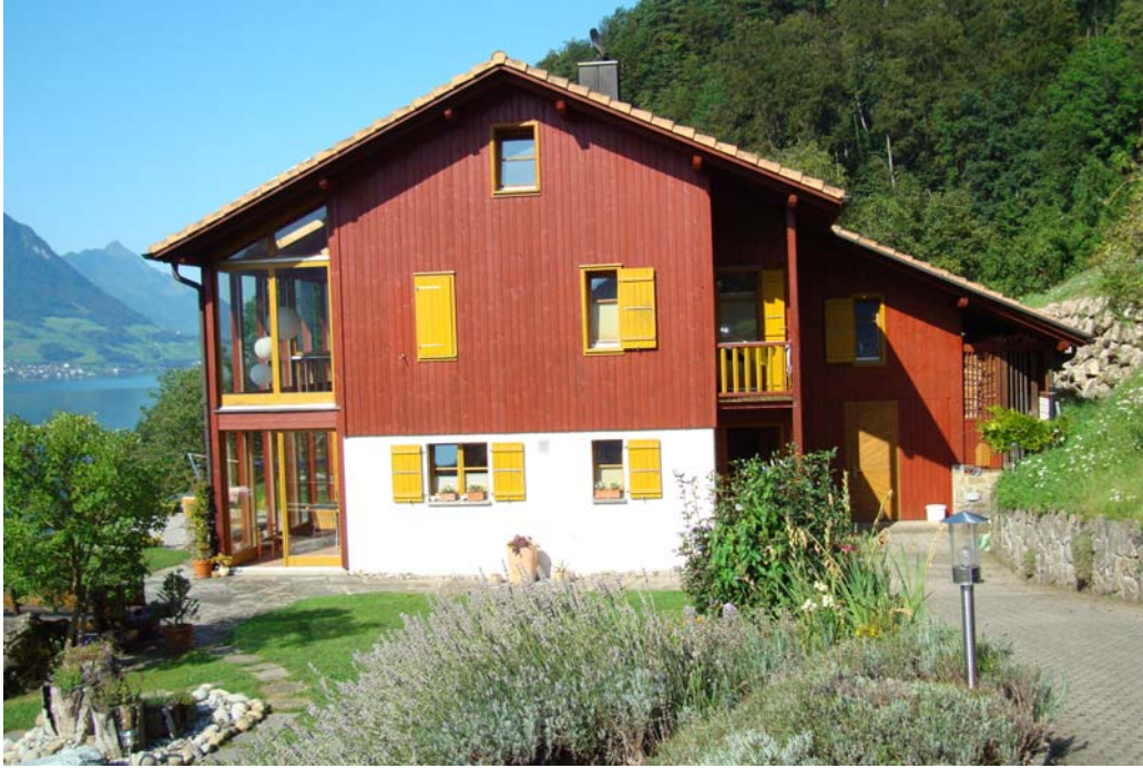
Das Gebäude besteht fast ausschliesslich aus natürlichen Baumaterialien. (Bild 3)
