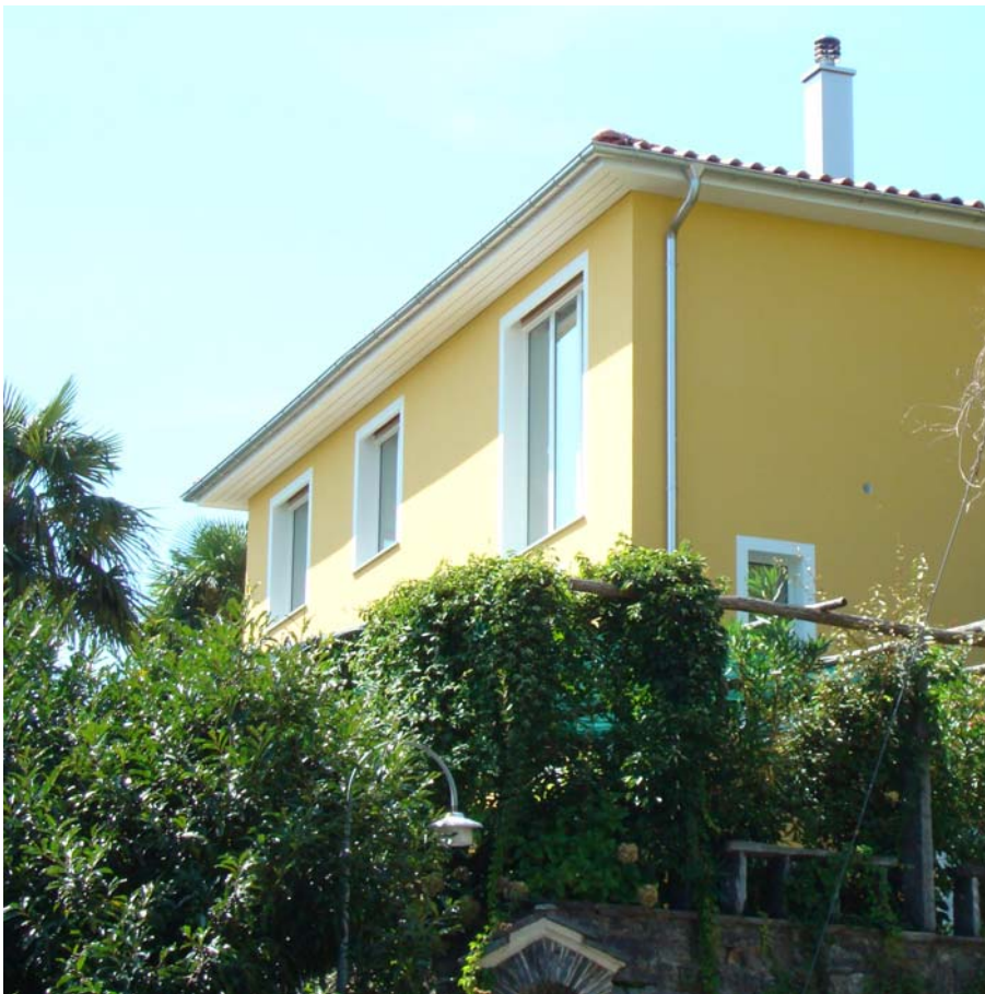
Blick auf das erweiterte Haus von einer alten Gasse aus (Bild 23)
