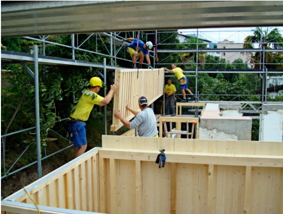
Dank Vorfabrikation verkürzte sich die Bauzeit merklich. (Bild 22)
